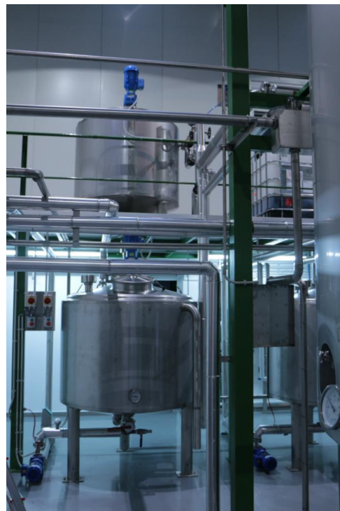
Πίνακας ελέγχου Δεξαμενές τροφοδοσίας
