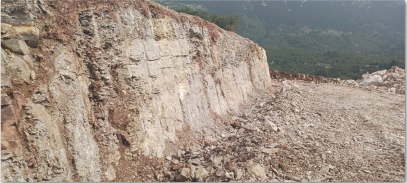
Αποτέλεσμα προρηγμάτωσης σε ένα δύσκολο με ασυνέχειες πέτρωμα.
